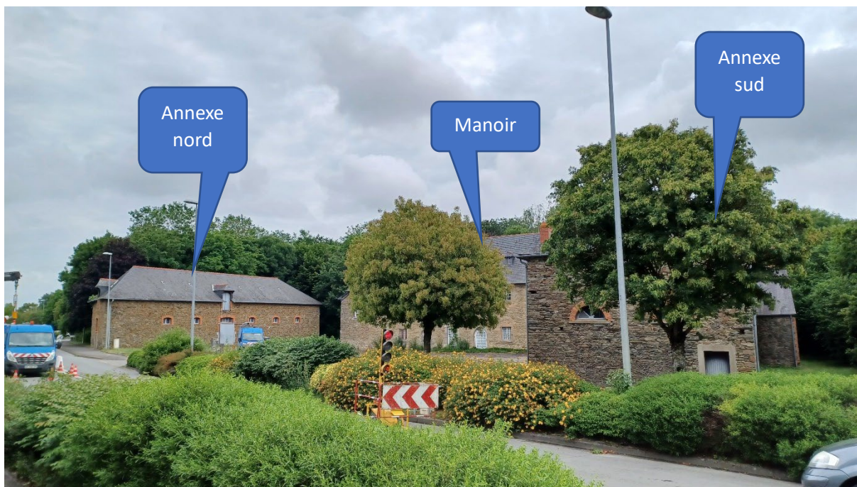
Vue sur la cour depuis la route de Chantepie
