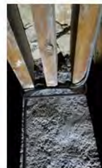
Poutres et interstices
