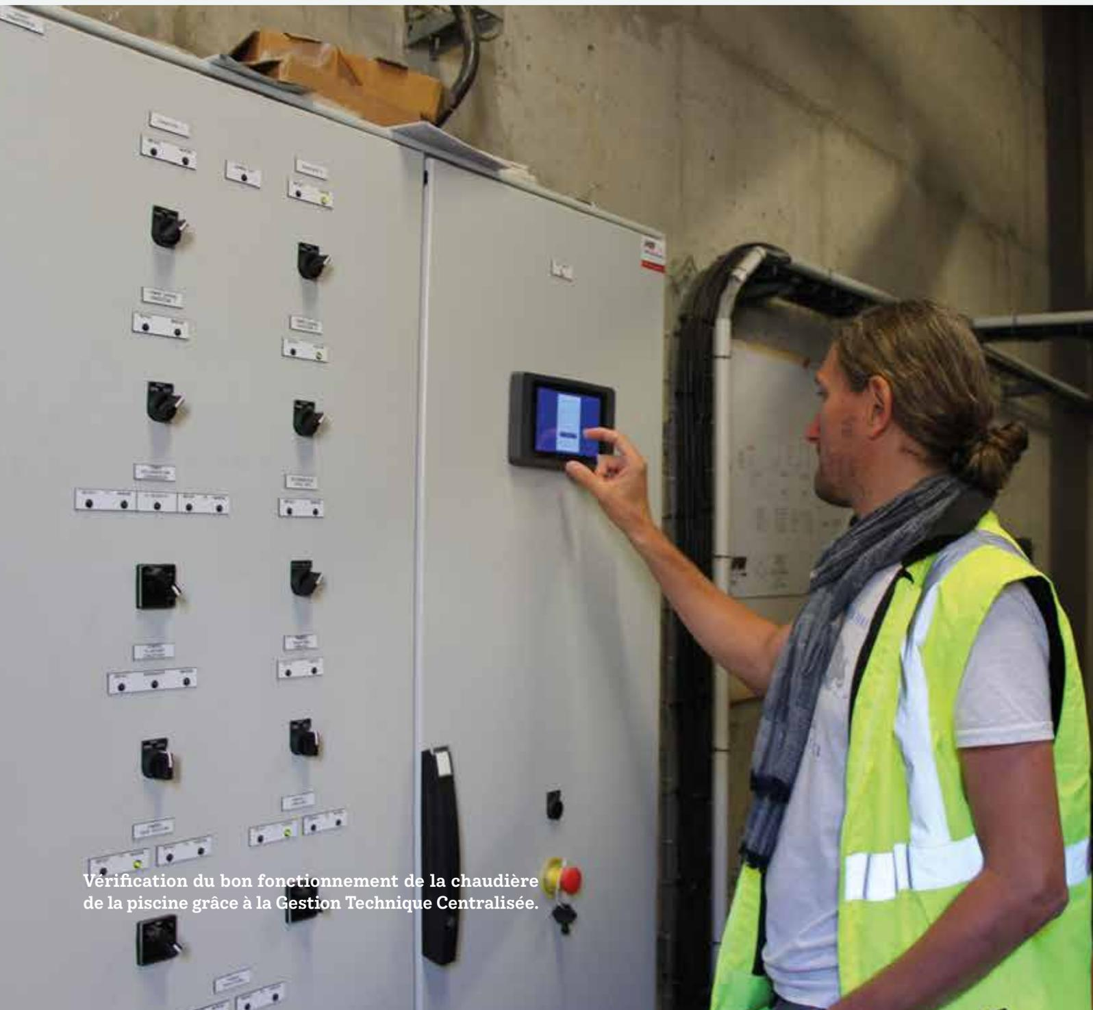
Vérification du bon fonctionnement de la chaudière de la piscine grâce à la Gestion Technique Centralisée.
