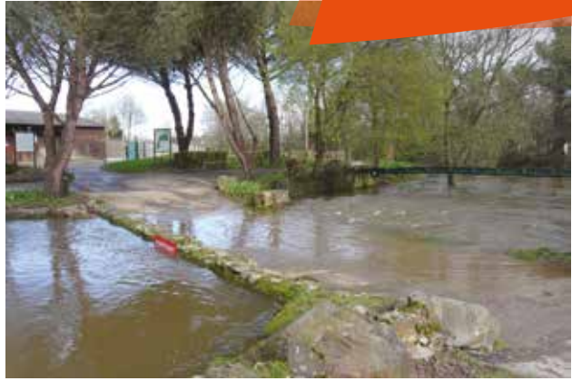
La Vilaine en crue a rendu le parcours du golf impraticable et inaccessible. Les habitations n'ont pas été impactées par la montée des eaux.
