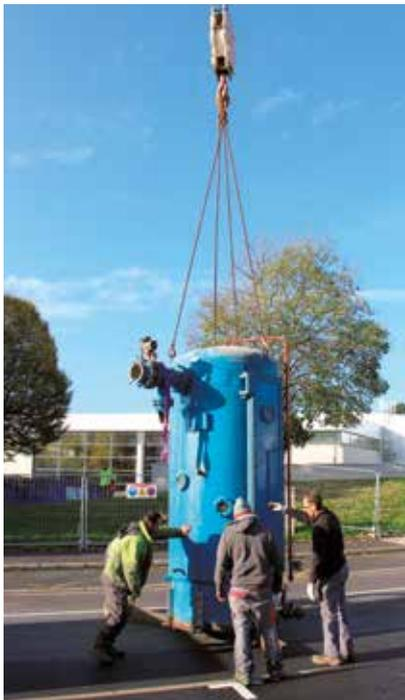
Mercredi 13 novembre, une grue a été déployée pour enlever les cuves à filtre de la piscine. Les cuves, qui dataient de 1986 (époque de la piscine Tournesol) vont être remplacées par des cuves à filtre
