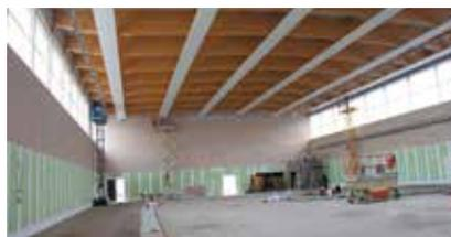
Un nouvel éclairage LED a été réalisé ainsi que l'isolation à l'Espace Sportif Bourgneuil (Cosec). Les autres étapes de la rénovation ont concerné la peinture, le ravalement de façade et la pose du sol sportif. La fin des travaux est prévue pour la fin 2015 et l'ouverture de la salle en janvier 2016.
