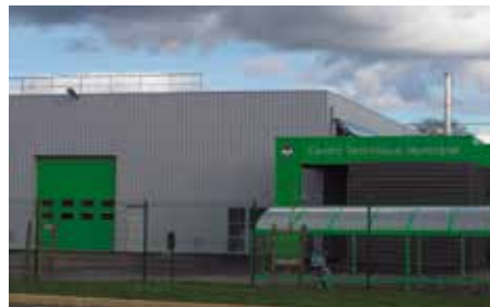
Centre technique municipal (2011). Bâtiment entièrement conçu à l'énergie positive
