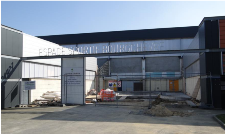
Photo Travaux en cours
