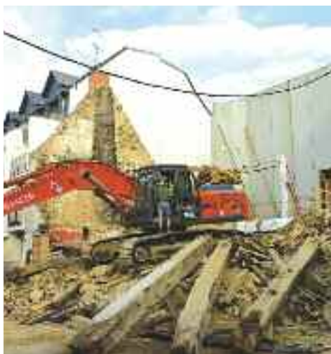
L'ancienne boucherie du cours de la Vilaine a été démolie.
