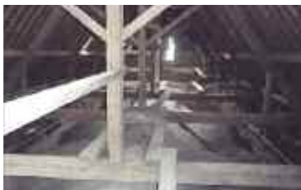
Un platelage va être réalisé dans les combles pour sécuriser les lieux.
