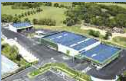
Le nouveau centre technique municipal permet aux agents de travailler dans de meilleures conditions.
