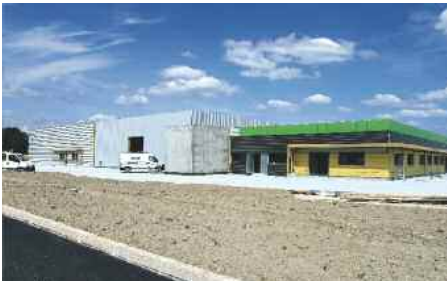
Les services Techniques de la Ville disposeront d'un outil très performant.
