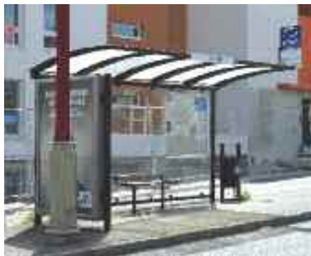
Le programme sera achevé après l'aménagement de ce quai de l'arrêt Bel Air.
