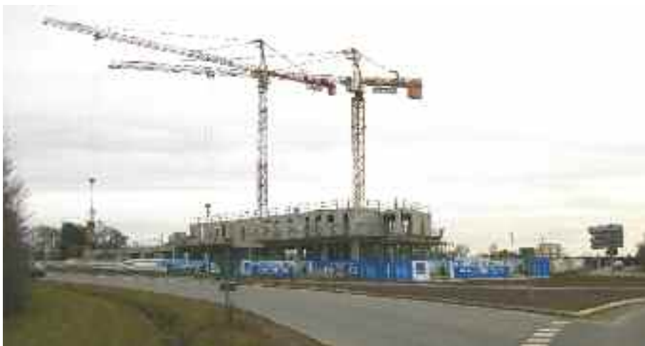
Secteur Atalante/Champs Blancs : d'importants chantiers de construction sont en cours, signe d'un dynamisme économique lié à l'attractivité des gros projets urbains à venir sur ce site.
